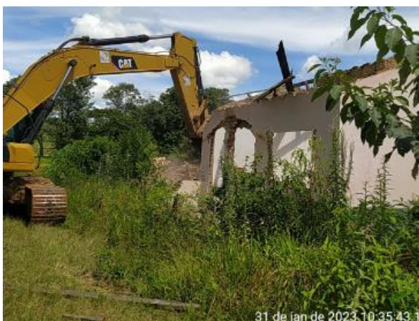
Foto 5 – Início da demolição estrutura 29D. (Foto: 31/01/2023)
