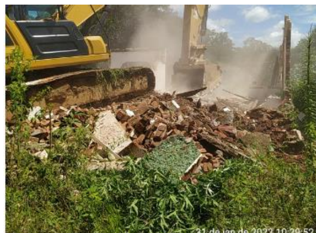
Foto 6 – Início da demolição estrutura 29E. (Foto: 31/01/2023)
