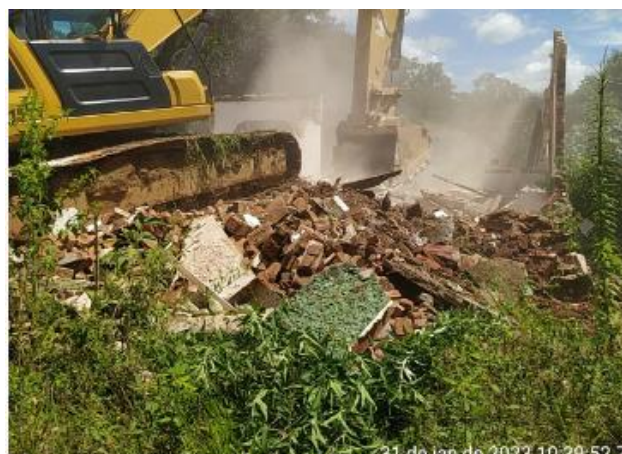
Foto 8 – Início da demolição estrutura 29E. (Foto: 31/01/2023)
