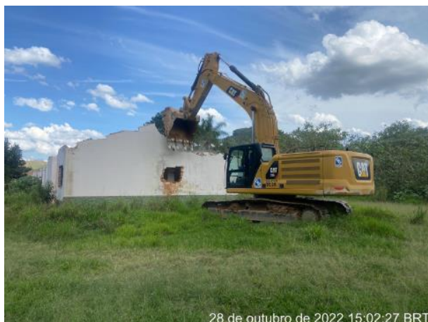
Foto 1 – Início da demolição. (Foto: 28/10/2022)
