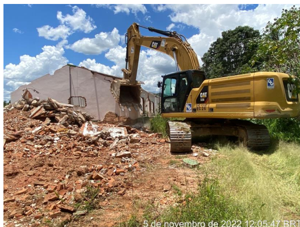
Foto 3 – Início da demolição. (Foto: 05/11/2022)
