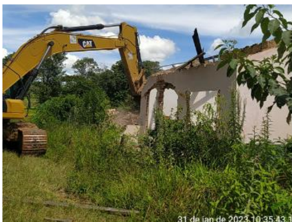
Foto 7 – Início da demolição estrutura 29D. (Foto: 31/01/2023)
